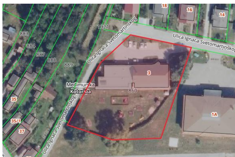
Slika 22. Dogradnja sanitarnog čvora u dječjem vrtiću Kotoriba
